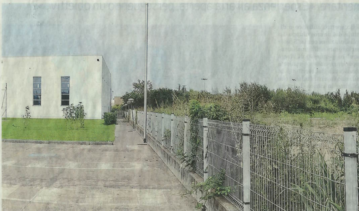
A destra, l'area dove sorgerà la nuova scuola dell'infanzia e asilo nido, su un terreno limitrofo al campus scolastico
