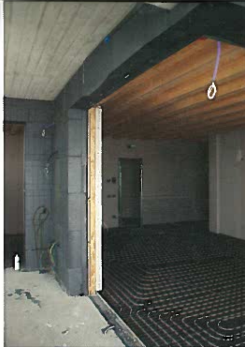
Cappotto e pavimento radiante
