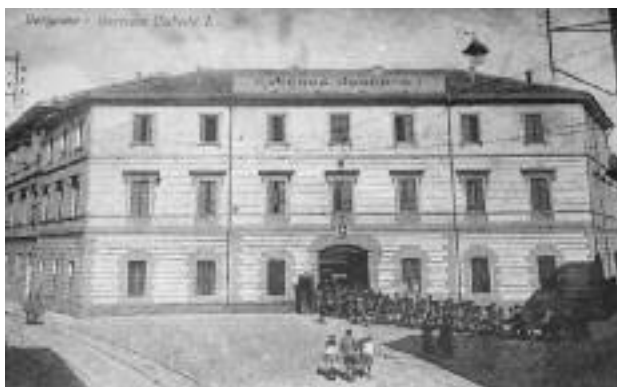
Fig. 33. Facciata principale della caserma.
