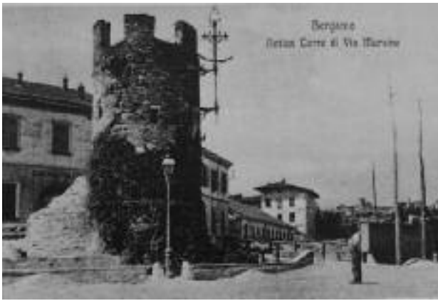
Fig. 28. Il complesso prima della demolizione di San Raffaele e del soprizzo della Colleoni (1901 circa).
