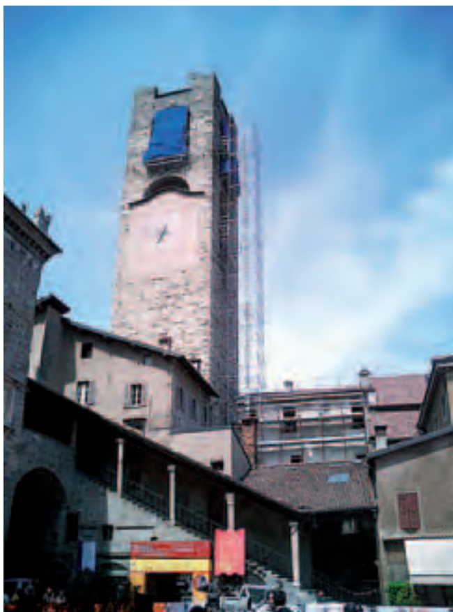
Fig.1: I restauri della torre: il ponteggio esterno
