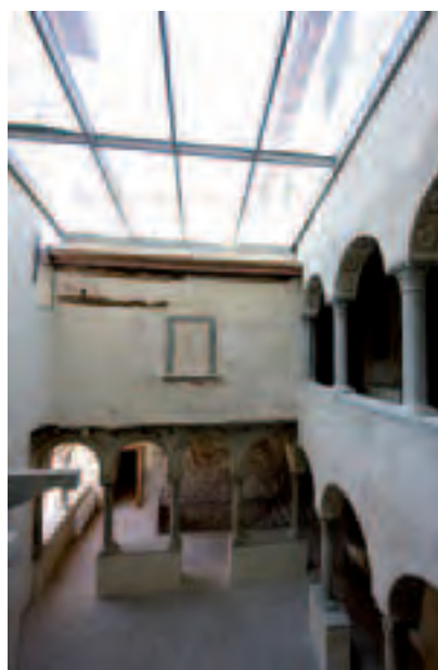
Fig.3: Copertura del chiostro al piano primo
