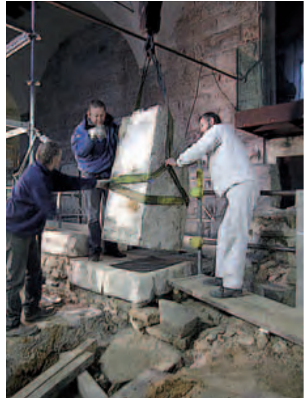
Fig.6: Il ricollocamento dello stipite marmoreo della soglia (US 708 – US 709) con l'ausilio di braccio telescopico.
