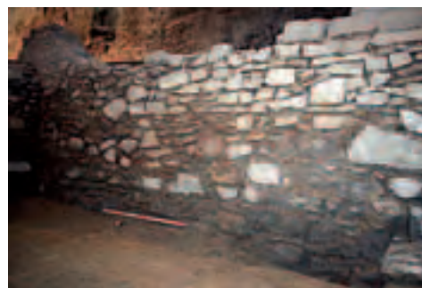
Fig.9: Perimetrale sud del complesso forense.
