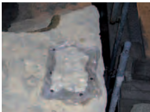
Fig.3: Campione di consolidamento ad impacco con etil silicato.
