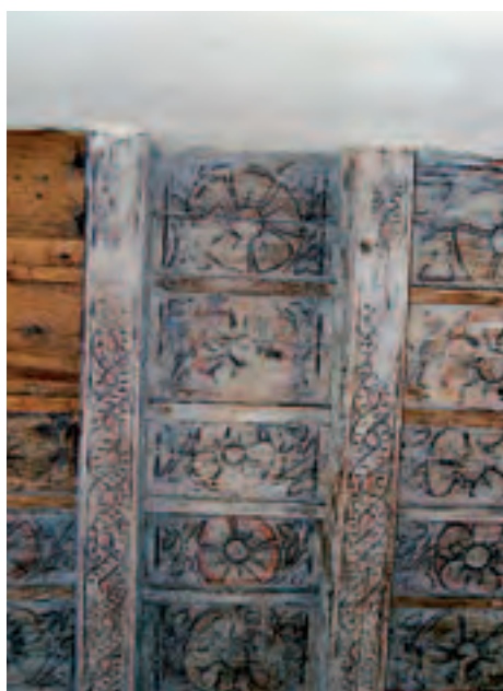
Fig.2: Soffitto ligneo al piano primo (dopo il restauro).
