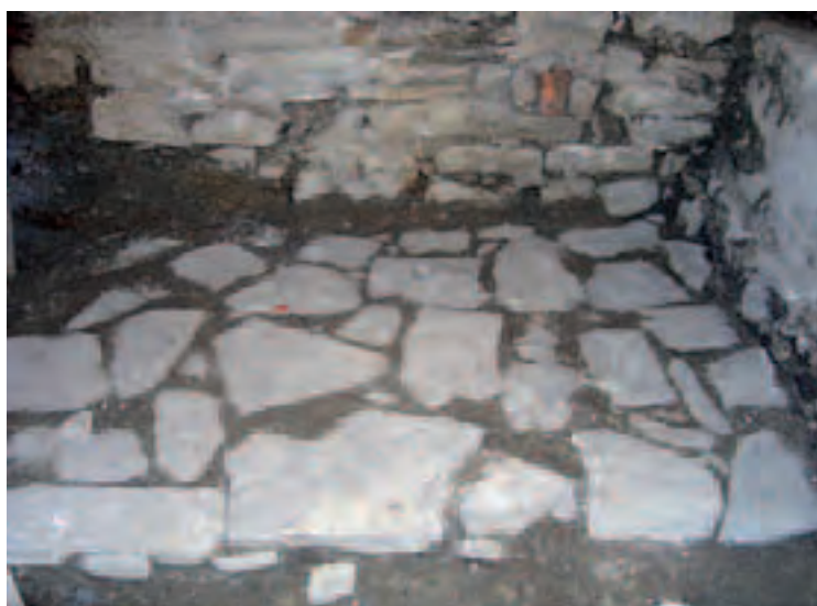
Fig.1: Stato di conservazione basolato (US 33 ante restauro 1 ).
