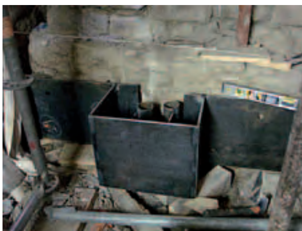
Fig.1: Plinto di fondazione della passerella.
